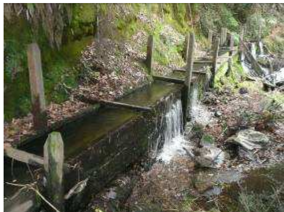
Foto 4.13. Canal creado para generar electricidad.
