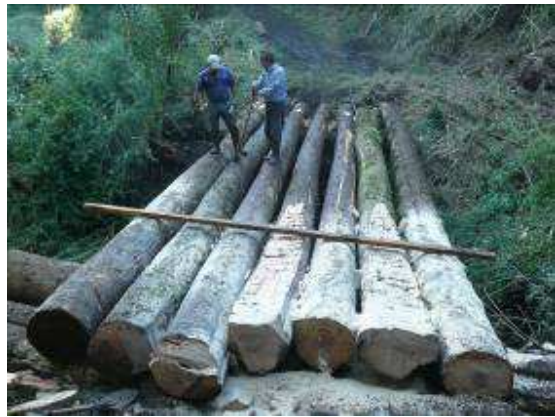
Foto 4.26. Puente en construcción.
